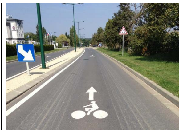
Voie étroite d'accès à un giratoire sur la D446 à Saclay
